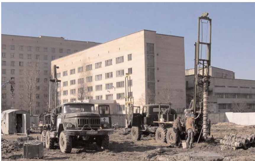
Буровые работы. Комплекс жилых домов на Ленинском пр. у больницы Костюшко
