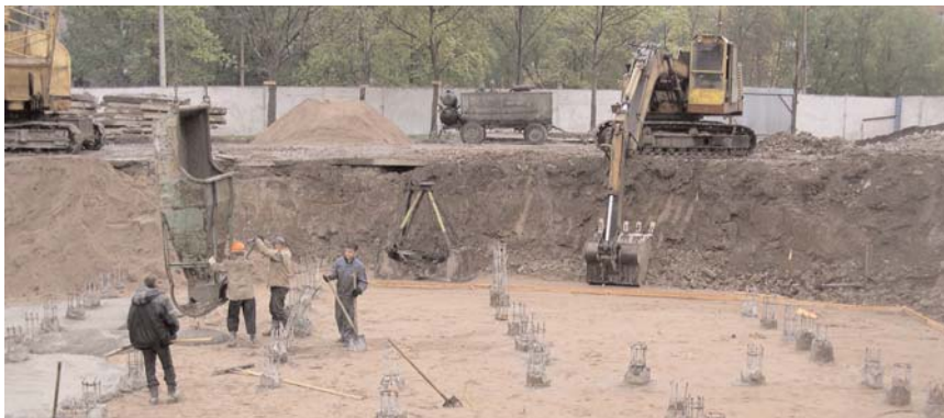
Свайные работы, строительство объекта на Дачном пр.
